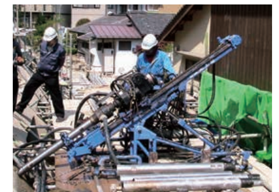
ESD40による掘削作業風景
